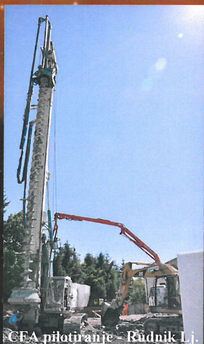
Pilotiranje - AC viadukta Studenčica - Čapljina, BiH
