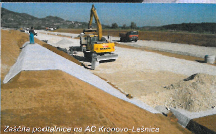
Zaščita podtalnice na AC Kronovo-Lesnica
