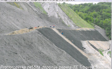
Protierozijska zaščita deponije pepela TE Trbovlje
