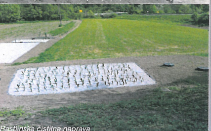
Rastlinska čistilna naprava
