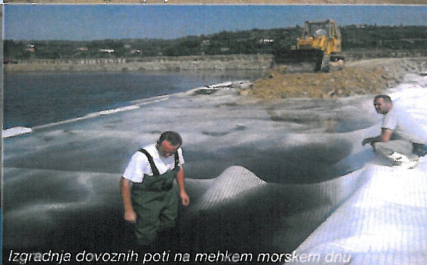
Izgradnja dovoznih poti na mehkem morskem dnu
